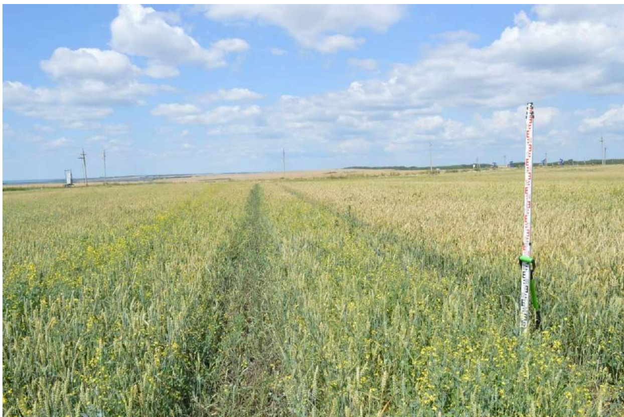
Илл. 19. Объект «Обустройство кустов скважин №№ 9910, 9918, 9924 Краснооктябрьского нефтяного месторождения АО «Шешмаойл». Общий вид куста скважин № 9910. Точка фотофиксации №5. Вид с ЮВ.
