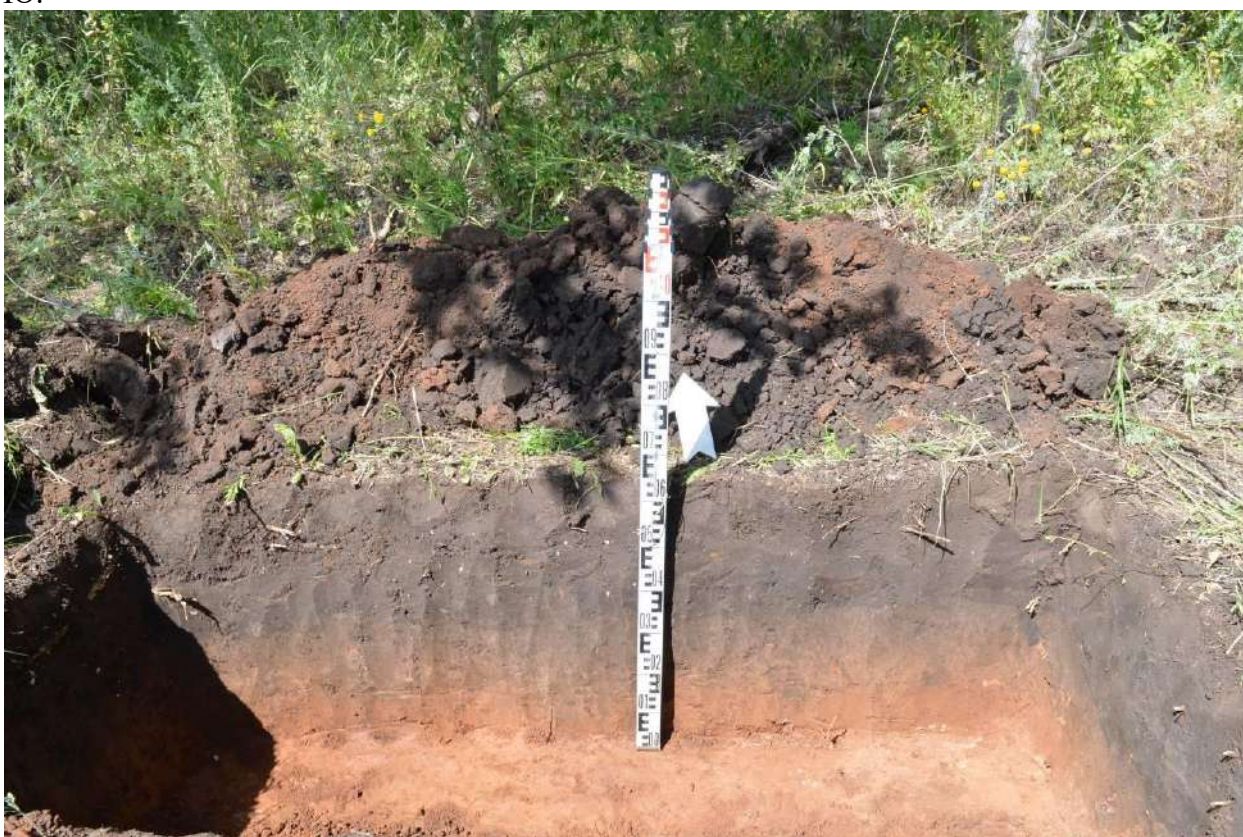
Илл. 50. Объект «Обустройство кустов скважин №№ 9910, 9918, 9924 Краснооктябрьского нефтяного месторождения АО «Шешмаойл». Северная стенка рекогносцировочного шурфа № 4. Вид с Ю.
