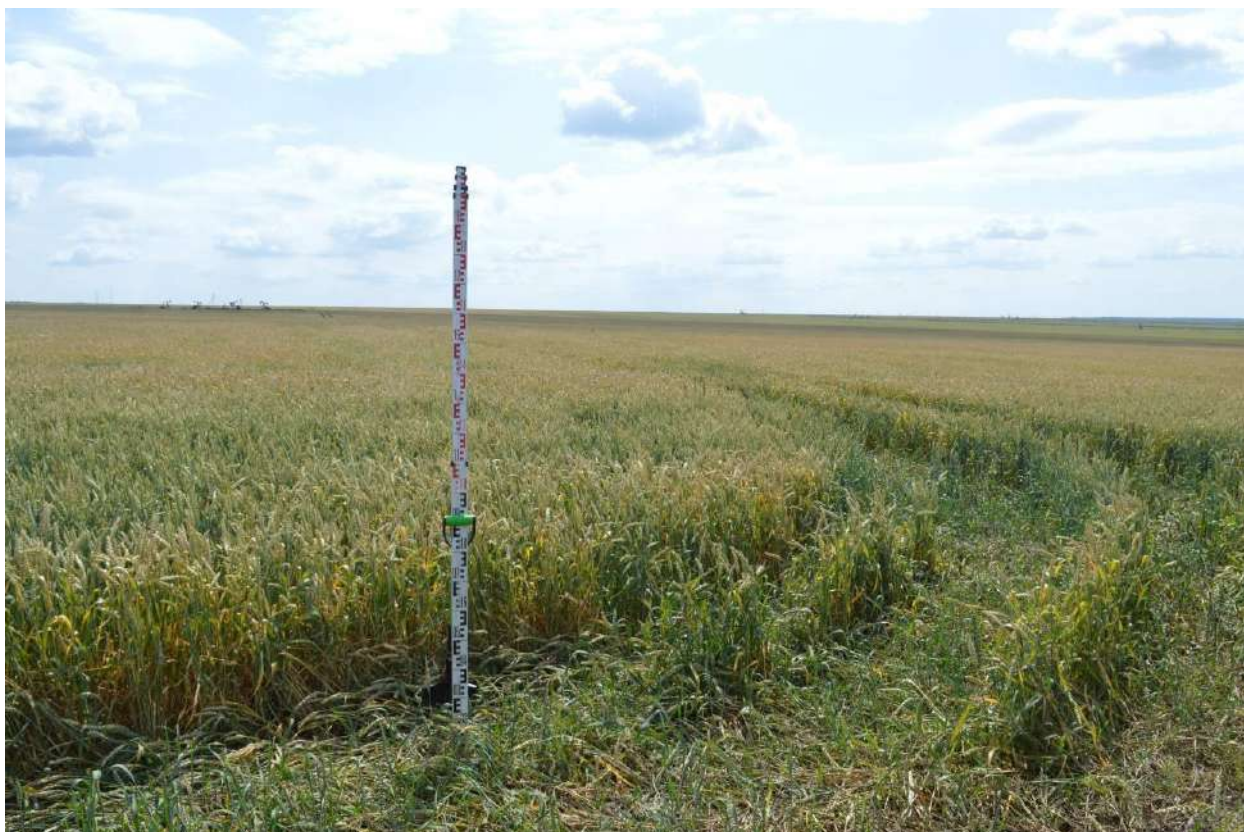
Илл. 13. Объект «Обустройство кустов скважин №№ 9910, 9918, 9924 Краснооктябрьского нефтяного месторождения АО «Шешмаойл». Общий вид на трассу ВЛ к кусту скважин № 9924. Точка фотофиксации №2. Вид с З.
