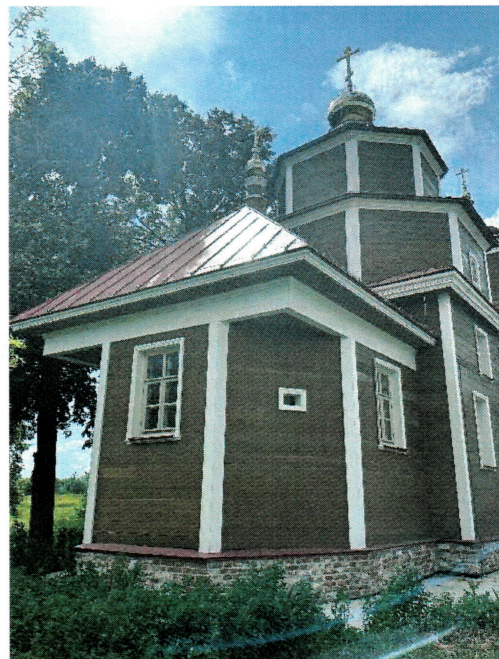
Местоположение оконных проемов апсиды
