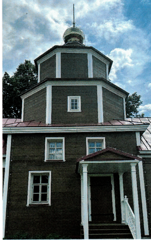
Местоположение оконных проемов восьмериков церкви
