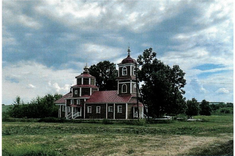
Общий вид церкви с северо-запада
