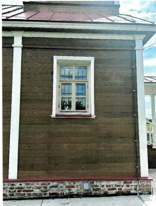
Характер оформления столярных заполнений оконных проемов, профильных наличников, кованых оконных решеток. Вид на западный фасад колокольни
