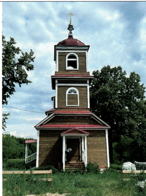
Местоположение входа по центральной оси западного фасада колокольни
